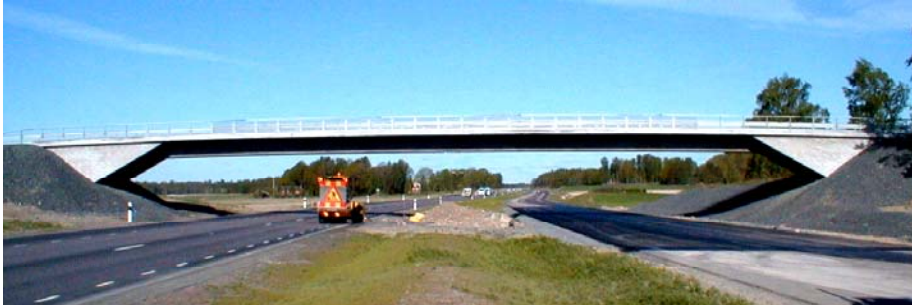
Figur 9 Mellanstödslös bro i högpresterande betong
