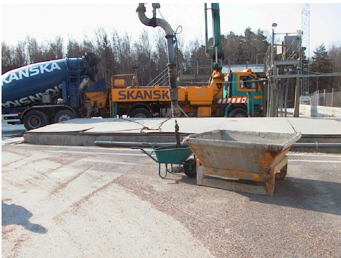
Figur 6 Pumpning av högpresterande betong i Solna betongfabriken
